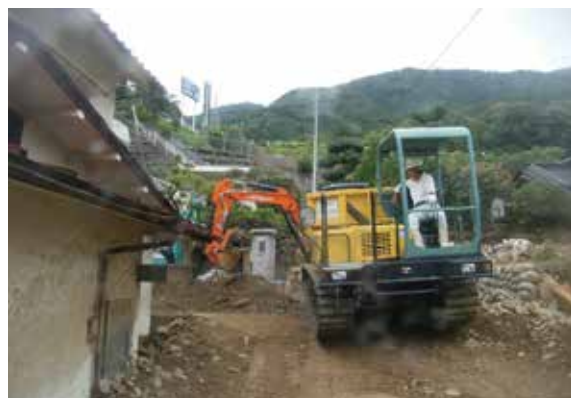
車両の進入が困難な為、不整地運搬車にて土砂等を搬出した。
