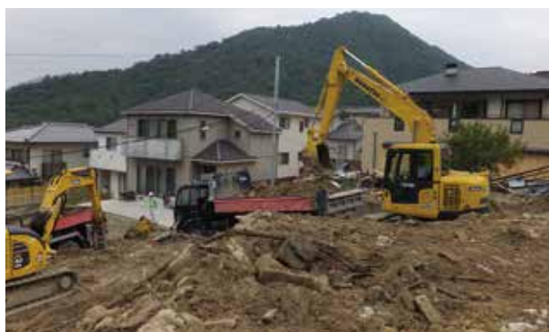
大型建設機械を使用した復旧作業
