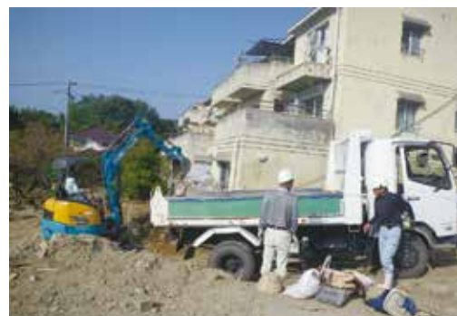
県営住宅廻りの土砂土石の撤去状況。バックホウにて土砂をダンプへ積み込み搬出した。
