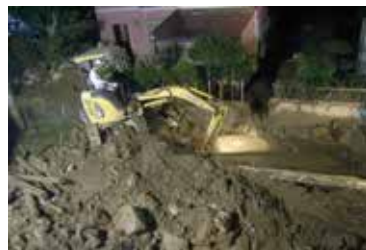
堆積土撤去状況
