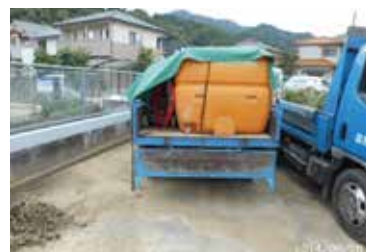
8 月 28 日 汚泥撤去作業開始
