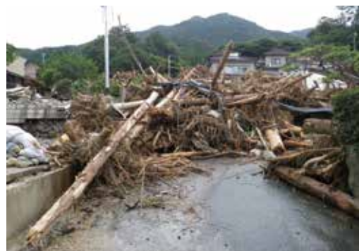
新建団地公園部被災後 土石及び流木で市道封鎖
