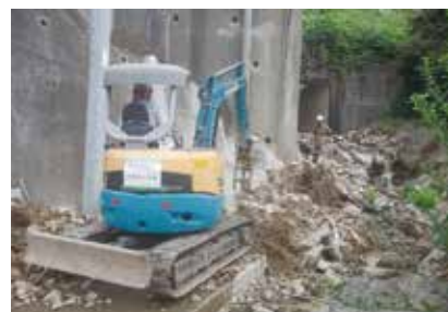
排水工に堆積した流木・土砂撤去
