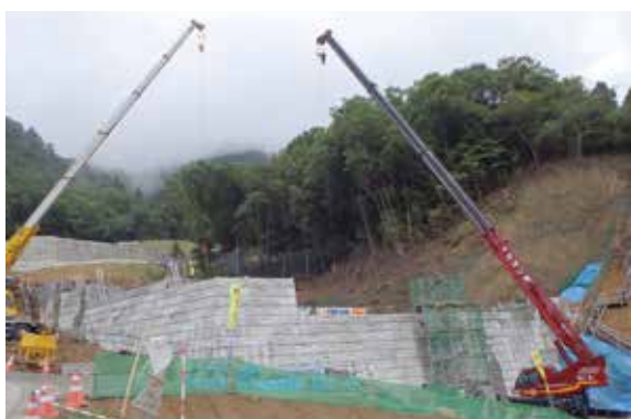
施工中（コンクリート打設） 平成 27 年 7 月 13 日
