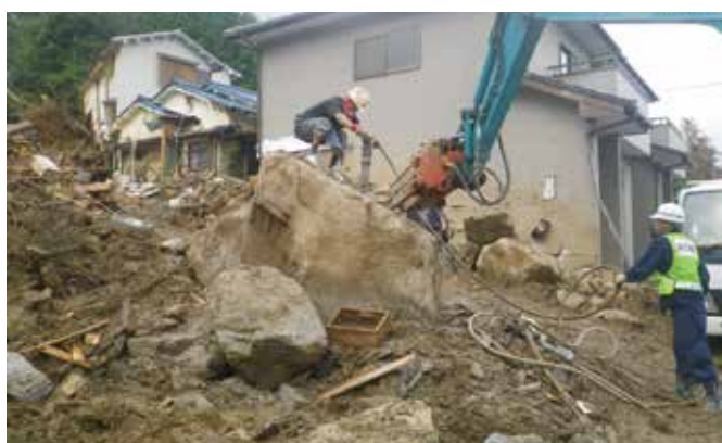
土石流により流出した巨石の破碎作業
