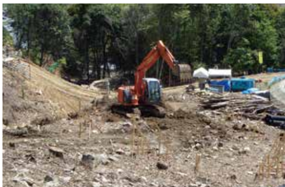
着手時（掘削作業） 平成 27 年 4 月 21 日
