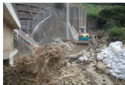
生活道路の堆積した流木・土砂撤去
