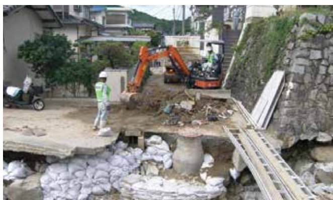
道路上の土砂撤去等復旧作業
