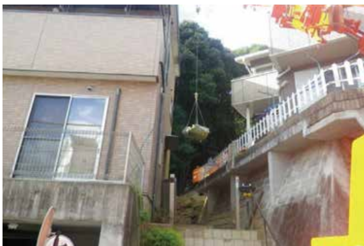
施工中 家屋の裏側なので、ダンプトラックに直接積み込めないため、クレーンを使用し、撤去、搬出を行いました。
