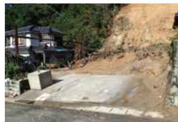
倒壊家屋撤去完了
