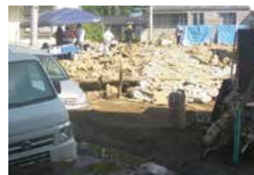
施工中 既存の道路は通行不可能なため、八木用水路上を搬出運搬経路とし、トヨタ駐車場よりクレーンにて搬出した。
