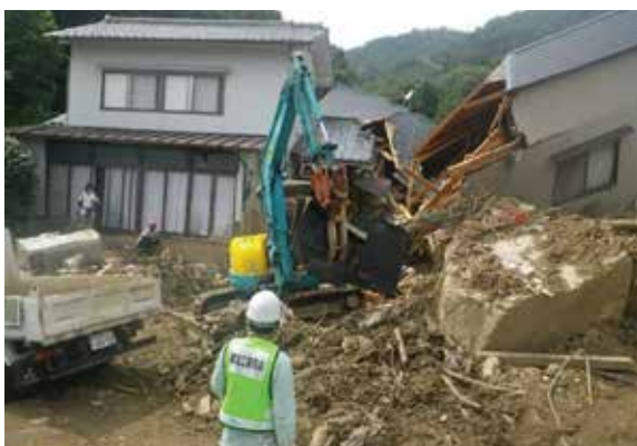
八木地区家屋解体状況
