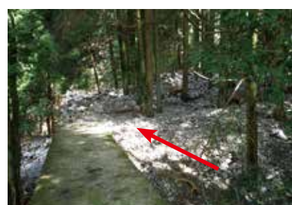
④ 上原川（上流）砂防堰堤
