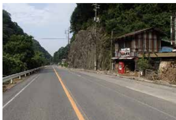
応急作業完了
