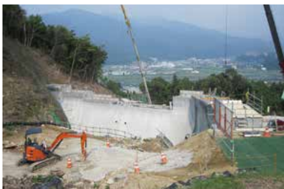
施工中（コンクリート打設） 平成 27 年 7 月 29 日
