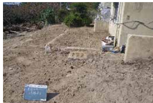
県営住宅廻りの土砂土石搬出完了
