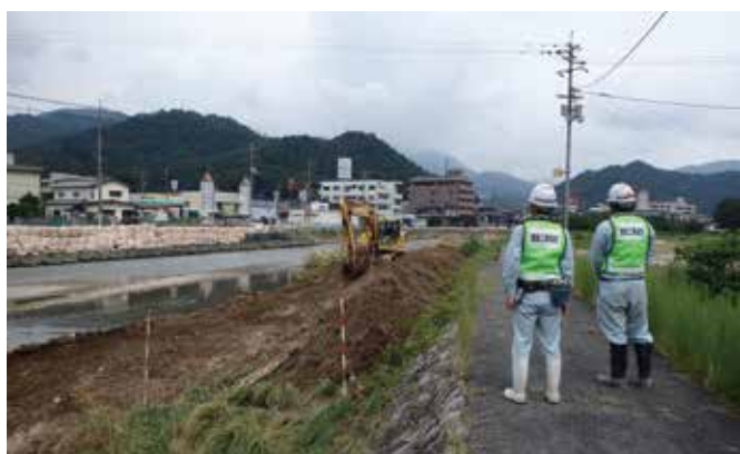
根谷川堤防補強（土のう積み作業）
