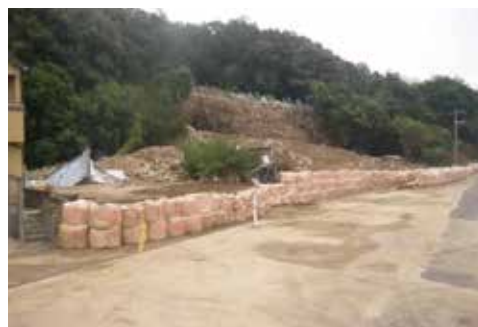
【施工完了】生活道路復旧と大型土のう設置完了
