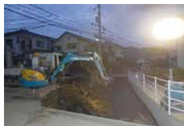
早期の排水確保の為、照明灯を段取使用
