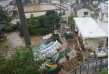
土のう袋にて築堤し、土砂を撤去
