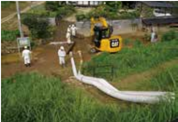
八木用水路に堆積した土砂をバックホウで搬出し釜場をもうける。
