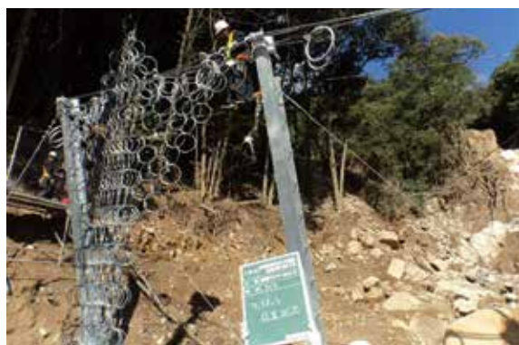
施工中 平成 26 年 10 月 23 日
