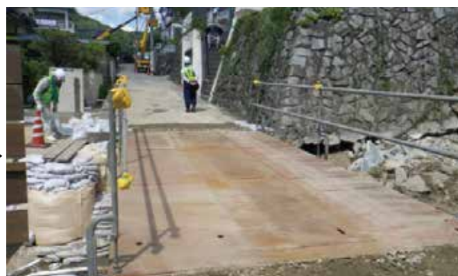
仮橋設置状況
