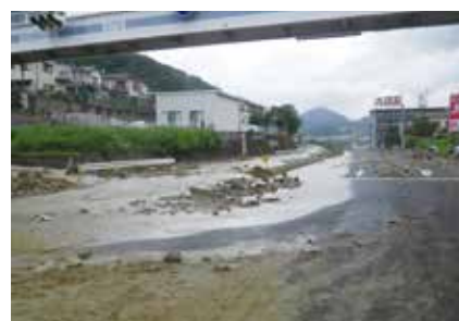
現場到着後の国道 54 号線の当初状況
