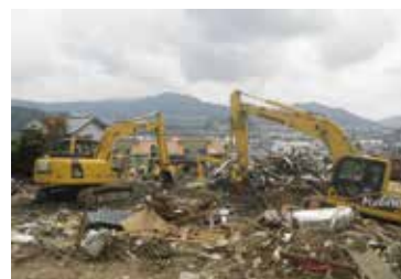
進入路確保（道路啓開状況）
