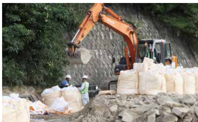
大型土のう設置作業
