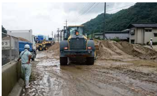
道路復旧作業（安佐北区大林 国道54号）
