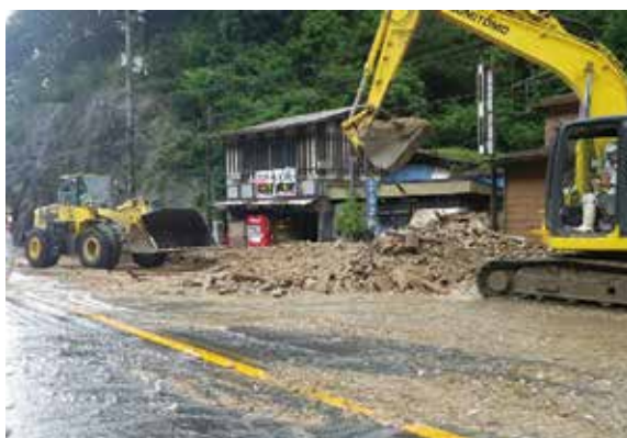
土砂撤去状況
