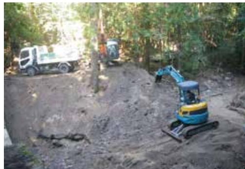
山倉川堰堤裏の大量の土砂、土石をダンプへ積み込み搬出した。
