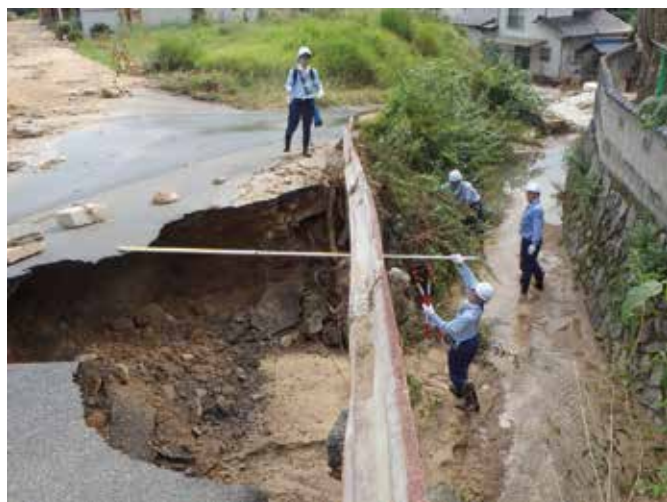
TEC-FORCE による河川の点検状況
