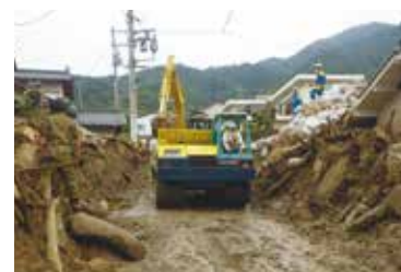
土砂・がれき撤去
