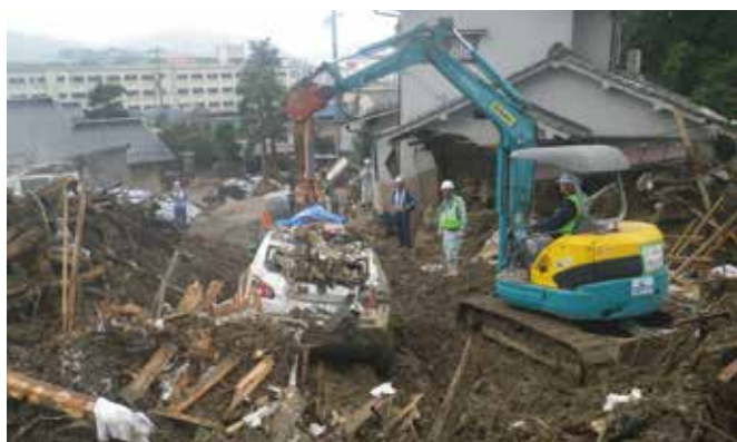
ガレキ撤去作業
