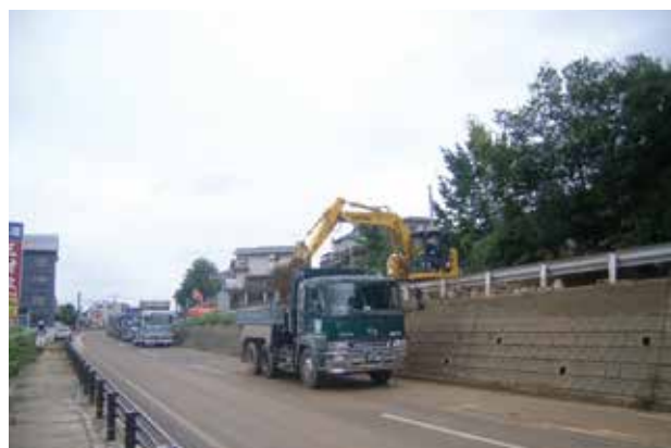
国道54号線の啓開作業として、ダンプトラック数十台による、土石流などの運搬作業を実施しました。運搬作業は夜間まで続けました。
