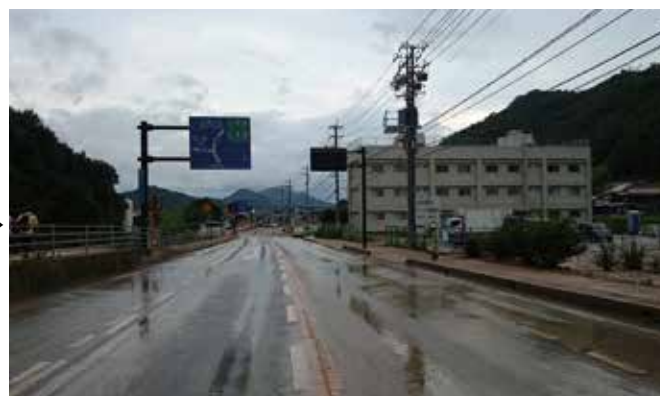
土石流撤去完了（8 月 20 日 16 時 40 分）
