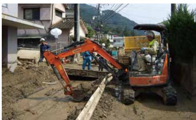
八木用水土砂撤去作業
