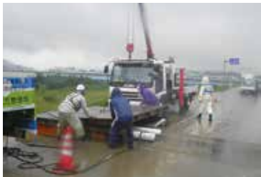
県道 177 号線の交通確保のためホースブリッジを製作した。
