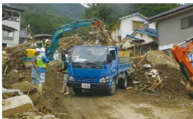
ガレキ撤去作業
