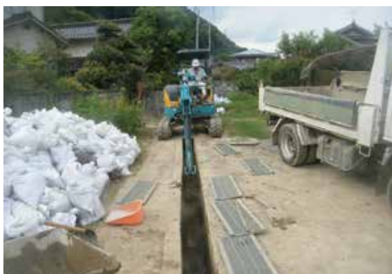
ミニバックホウにて狭く深い側溝の土砂を撤去した。
