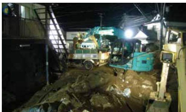
建設機械を使用した復旧作業
