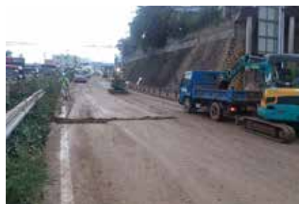
作業員、小型バックホウにより土砂撤去、運搬状況
