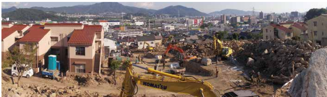
土砂撤去作業（安佐南区八木）
