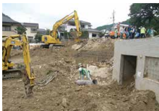
同上 土砂撤去状況 流木除去後土石撤去搬出
