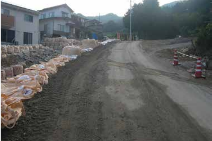
施工後 大型土のう及び盛土により道路幅員を確保
