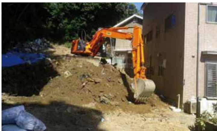
施工中 家屋の裏側の堆積土砂を撤去しました。
