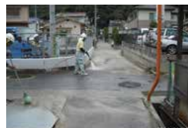
周辺道路清掃状況
