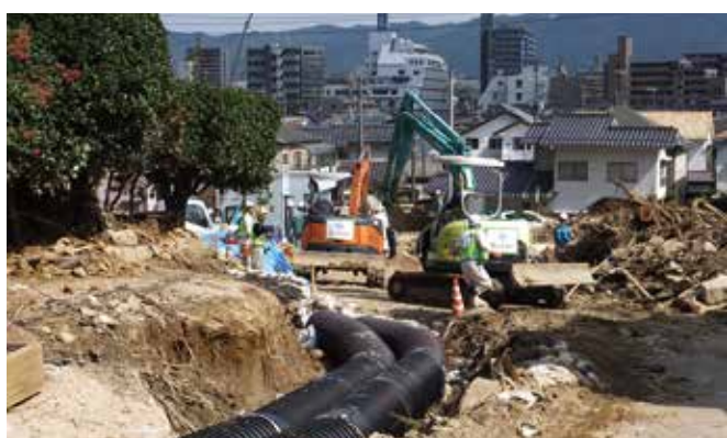
仮排水路設置作業
