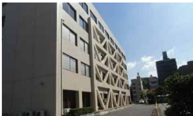
耐震補強工事
