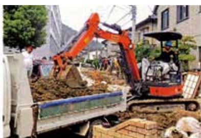
小型重機を駆使して道路啓開が進む＝27日午後、安佐南区八木地区で
