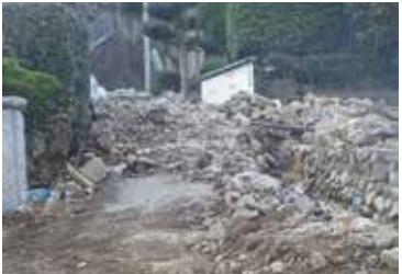
道路上は土砂・瓦礫で通行不能
