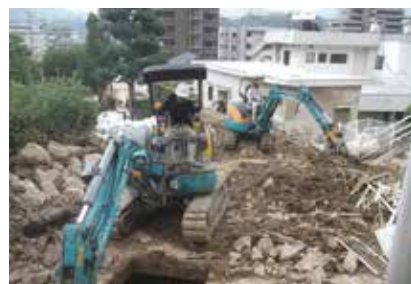
排水工の暗渠部に堆積した流木・土砂撤去
