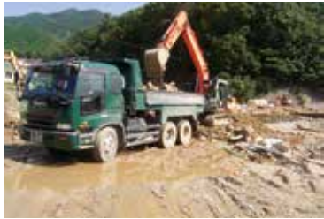
施工中 バックホウによる撤去状況。広い箇所では 10t ダンプトラックにより運搬。
