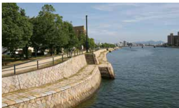
高潮被害を防ぐ高潮堤防
