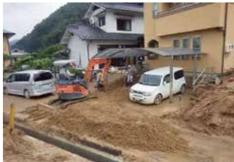
民地内の土砂撤去作業
