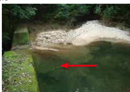
⑦ 山倉川砂防堰堤
