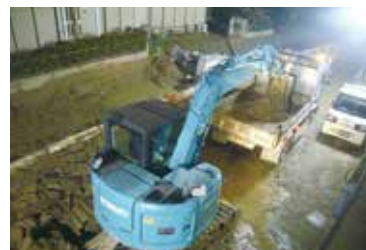
堆積土積込状況
