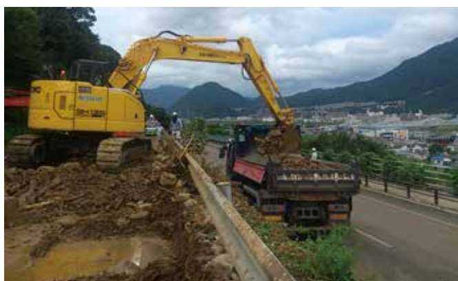
道路復旧作業（安佐南区八木 国道54号）
