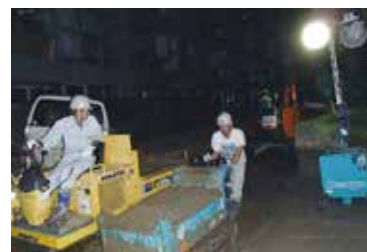
八木用水路土砂撤去
