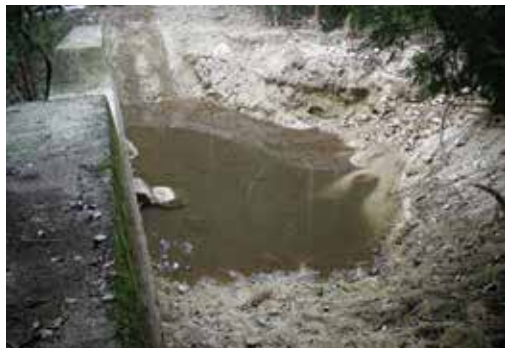
山倉川堰堤裏の土砂土石搬出完了
