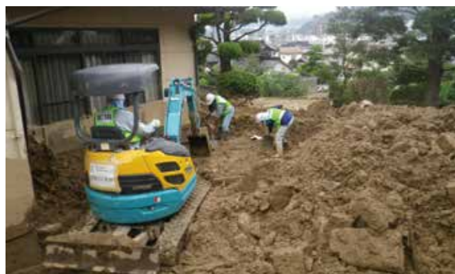
民地内の土砂撤去作業
