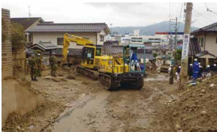
土砂・がれき撤去
