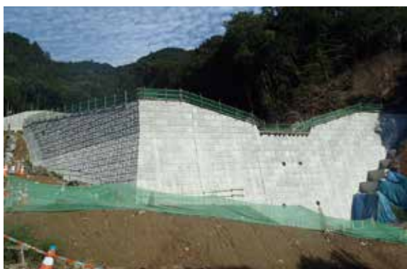
堤体完成 27 年 8 月 22 日
