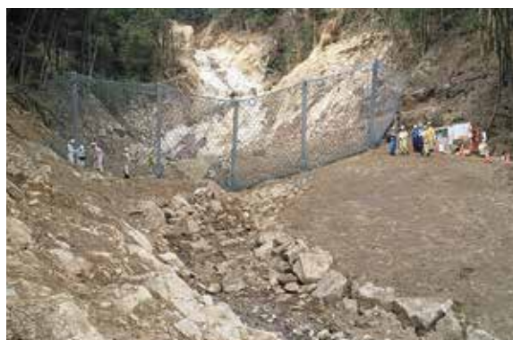
完成 平成 26 年 10 月 29 日
