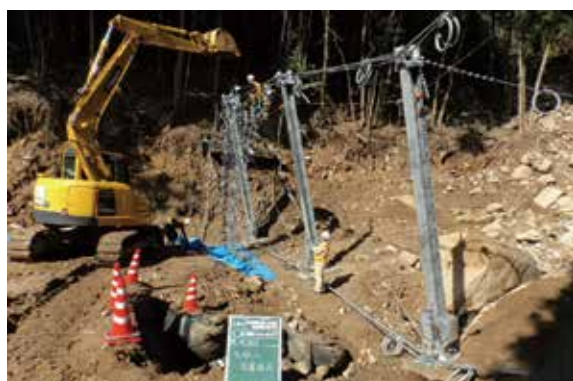
施工中 平成 26 年 10 月 22 日
