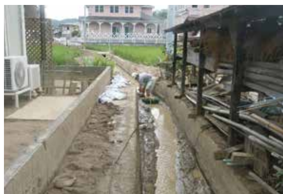
重機・車両が進入困難な用水路の土砂を人力にて撤去した。
