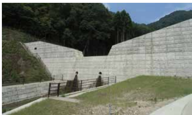
土砂災害を防ぐ砂防堰堤
