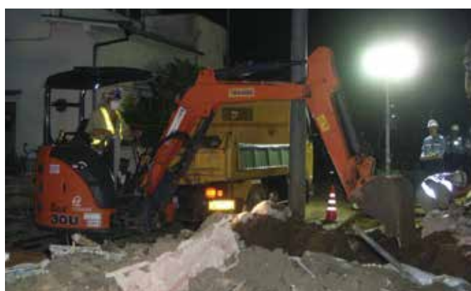
八木用水土砂撤去作業（夜間）
