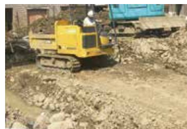
施工中 八木用水路上は不整地運搬車を使用して搬出した。
