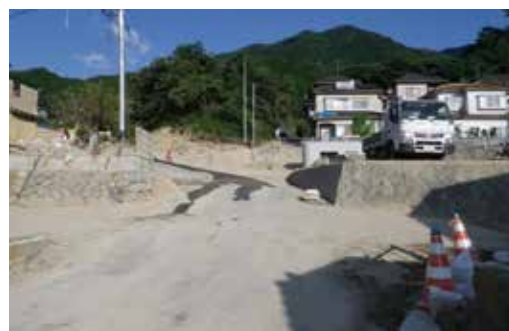
同上 復旧後 公園部及び市道機能復旧
