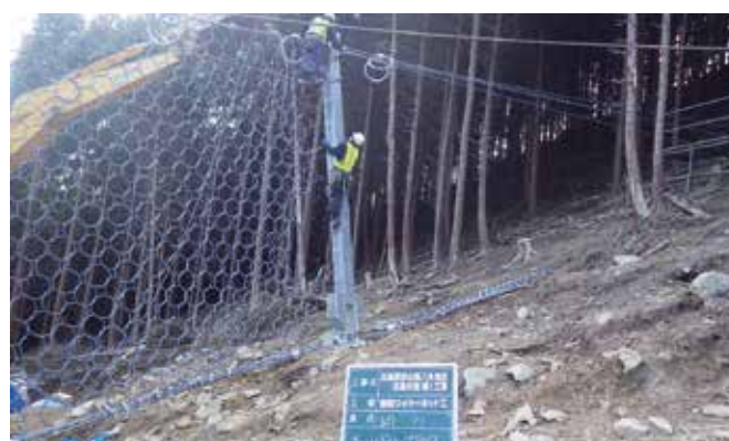
強靱ワイヤーネット施工状況
